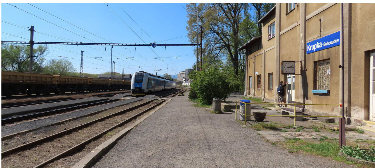
01 — Zastávka Krupka–Bohosudov získá dvě nová vnější nástupiště
