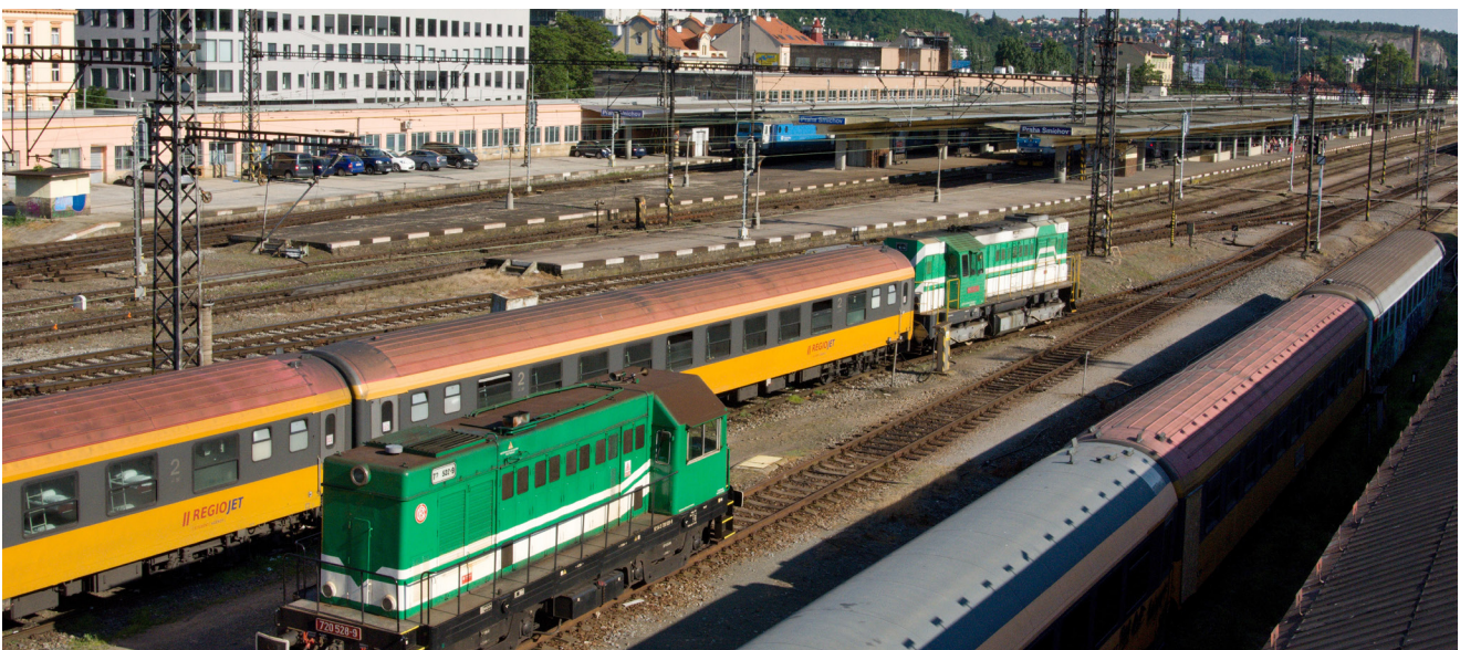
01 — Kolejiště ŽST Praha-Smíchov dozná během rekonstrukce značných změn
