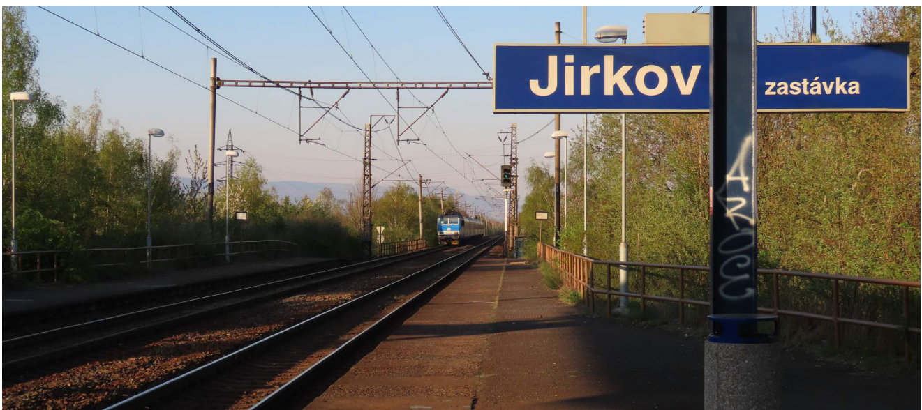
01 — Na zastávce v Jirkově se vybudují nová nástupiště
