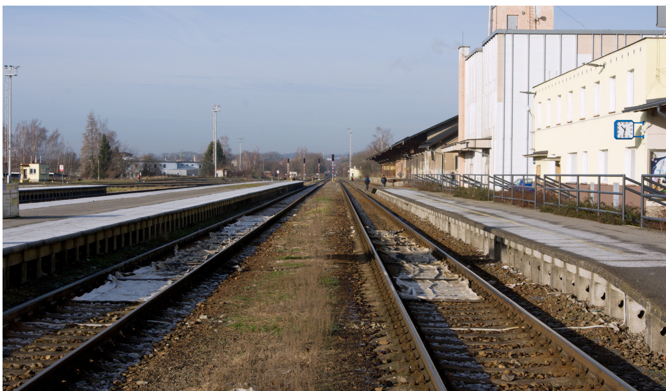
02 — V rámci stavby dojde ke komplexní rekonstrukci železničního svršku i spodku
